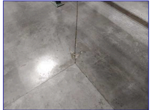
Spalling
